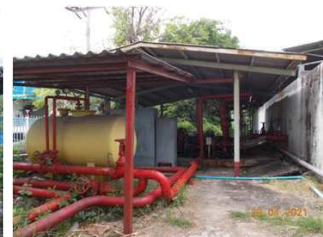
แนวท่อน้ำ ถัง/ท่อโฟม และอุปกรณ์ดับเพลิง
